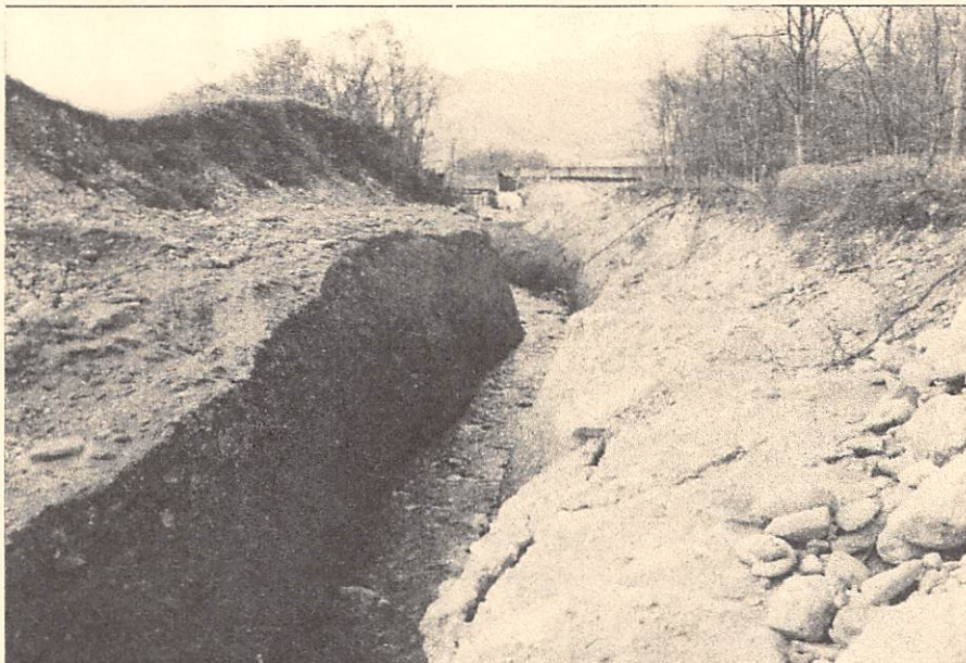
芽室川3号砂防堰堤直下の2016年9月台風により洗掘されたガリー 奥に見えるのが砂防堰堤。手前の平らな面が以前の河床面(撮影:在田一則氏)
